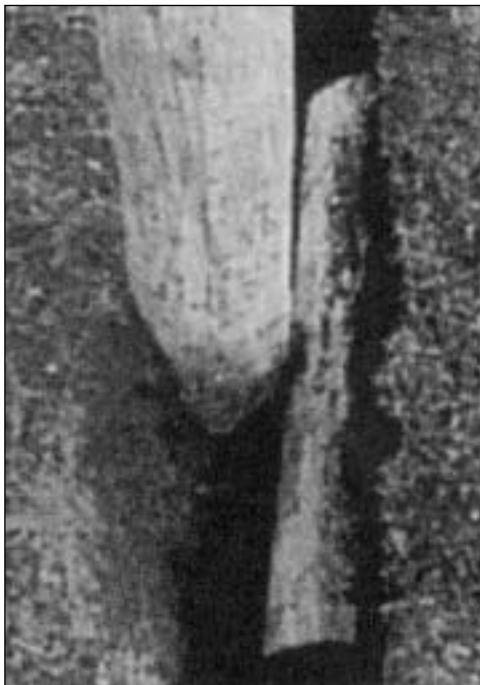
I blød jord er det en fordel at grave en tværligger ned foran hjørnepælen.
