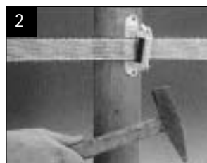
2 Tape føres gennem isolator og bankes fast.
