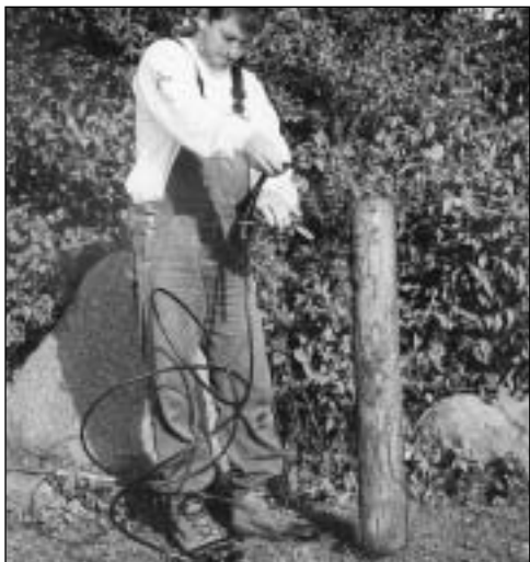
Så er hjørnepælen monteret - bemærk hældningen.
