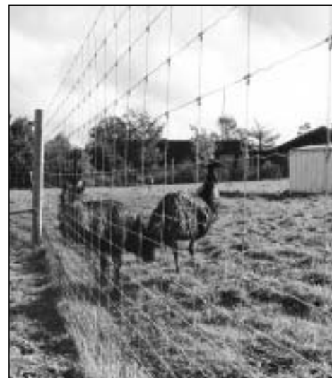
Nethegn i høj kvalitet. Bemærk de crimpede vandrette tråde.
