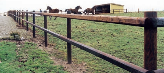
▲ Lægtehegn med tjæreimprægneret norsk skovfyr. Bruges ofte til ridebaner og showfolde. Stolperne er Ø12 cm og lægterne er kantskårde 8/10 cm.
