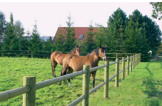
▲ "Texashegn" er en meget robust og holdbar løsning. Prismæssigt ligger den i toppen. Stolperne er Ø14 cm og lægterne Ø8 cm.
