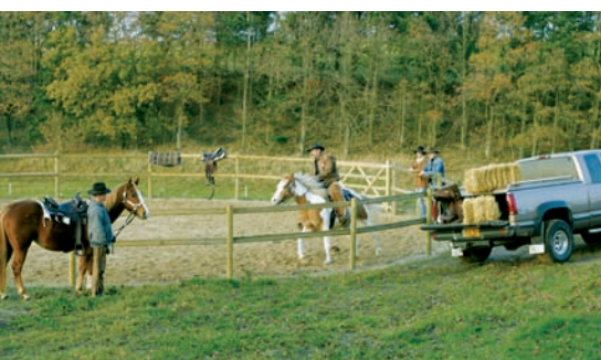
▲ Lægtehegn med i trykimprægneret norsk skovfyr. Stolperne er Ø10 cm og lægterne er kløvede Ø10 cm.
